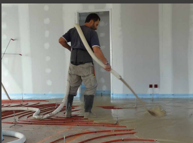
Door de precieze materiaaldosering kan een homogene en kwalitatief hoogwaardige vloeibare mortel worden geproduceerd.
