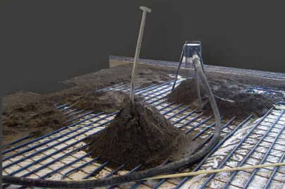
Volautomatisch worden zand, cement, water en additieven gemengd en getransporteerd naar de werkplek.
